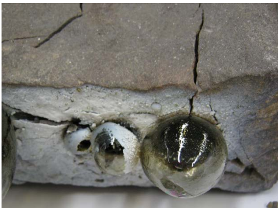
Abb. 1: Risse und Brüche durch thermische Expansion Fig. 1: Cracks and fissures caused by thermal expansion
